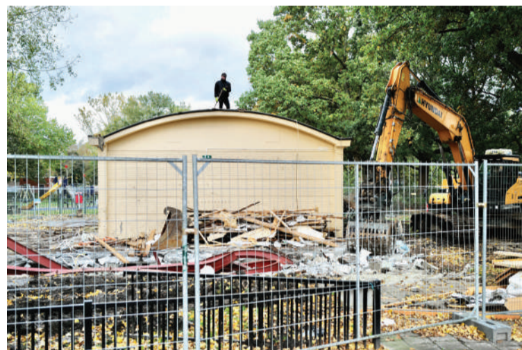
Onder: Het gebouwtje tijdens de sloop in november 2023.
